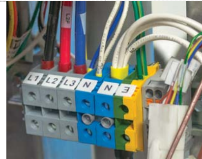
2. Aansluitblok WYE-voeding.
