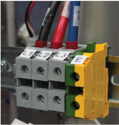
1. Aansluitblok Delta-voeding.
