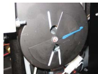
Отрывание пламени из-за слишком большого количества воздуха
